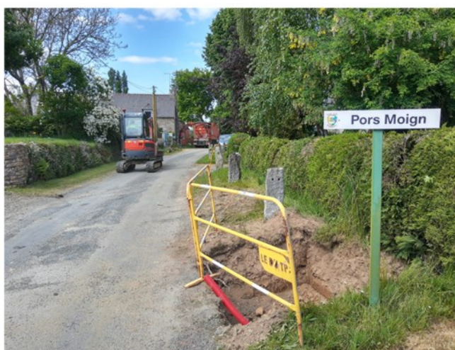
Effacement des réseaux à Pors Moign (entreprise Le Du)
