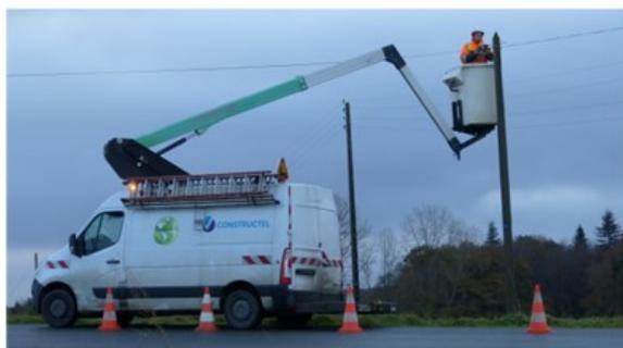
Quant à la société CONSTRUCTEL, elle a poursuivi le programme d'installation de la fibre optique en créant de nouvelles « chambres » et en changeant les poteaux téléphoniques pour y fixer un nouveau câble qui, passant le long du pont de la voie ferrée, relie les deux parties de la commune séparées par ladite voie. Pendant la durée de ces travaux, une circulation alternée avait été mise en place au niveau de « Kerouriou » pour assurer la sécurité des intervenants.
