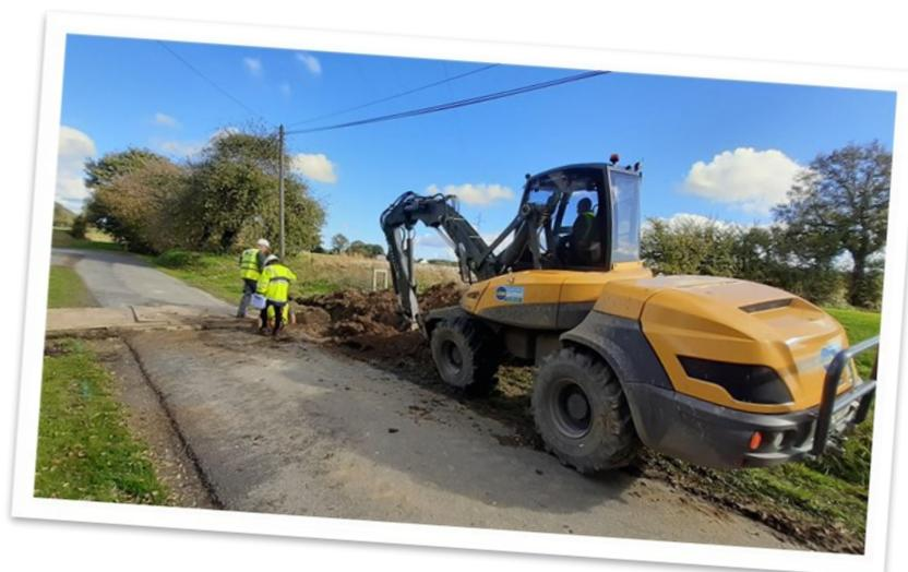
*Travaux d'effacement des réseaux électriques et télécom ainsi que renouvellement des conduites d'eau potable et extension de l'éclairage public en bas du bourg*
